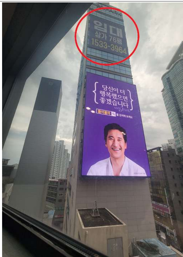
갑제10호증 피고측 건물 상단부
